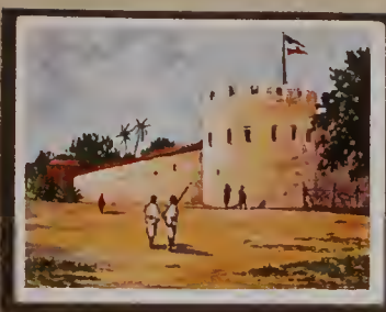
86 Feste von Waanja am Südrand des Viktoriasees. Sie lag, um bei etwaigen Aufständen besser verteidigt werden zu können, auf einem Hügel. In ihr waren zwei Bataillone der 14. Kompanie der Schutztruppe untergebracht.
